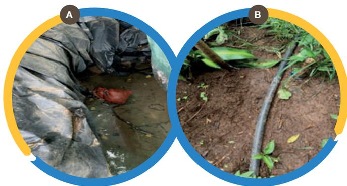
Figura 7. A. Pequeño reservorio hecho forrado con plástico. B. Conexión a mangueras. Atenas, Costa Rica, 2021. Fuente: Información propia
