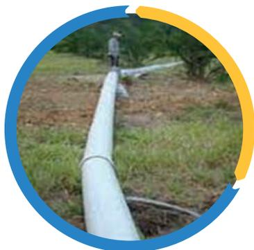
Figura14. Después de salida del tubo se instala la tubería de conducción. Atenas, Costa Rica, 2021.
