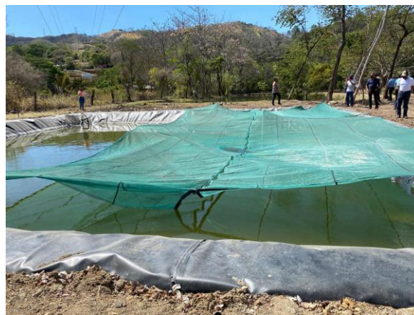
Figura 5. Reservorio con geomembrana de 500 m 3 .
