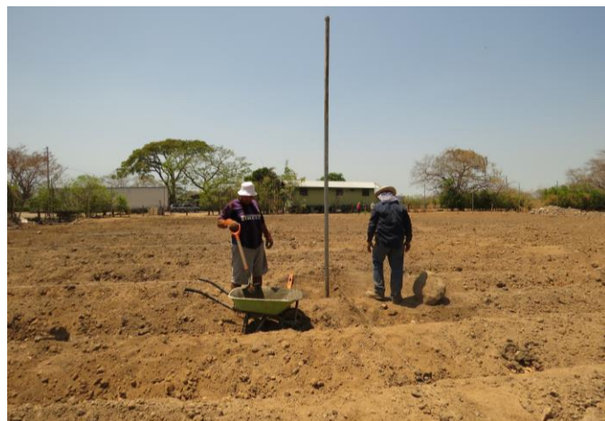
Figura 1. Construcción del módulo y preparación del terreno.
