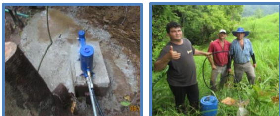
Figura 3. Imagen del ariete instalado y visto bueno del productor, Sr. Jhonny Quirós haciendo constar que cuenta con suministro de agua en las partes altas y apartos de la misma.
