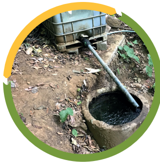
Figura 2. Tanque y tubería de alimentación. Fuente: INTA, 2018.
