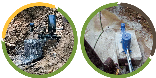
Figura 1. Bomba de ariete. Fuente: INTA, 2018.
