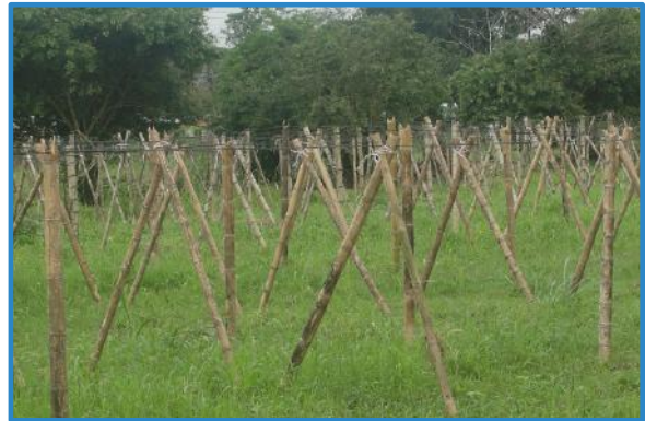
Figura 5. Colocación de cañas de bambú entre la línea de soportes para un mejor sostén de la estructura. Pococí, Costa Rica, 2016.
