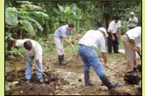
Recolección de material y echura de la zanja de 30 cms de profundidad
