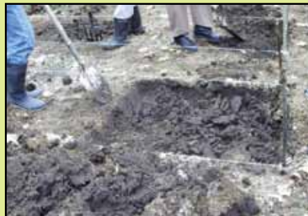
Colocación de primera capa del material seco
